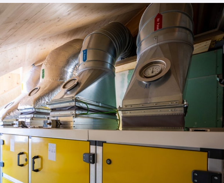
Die kontrollierte Lüftung mit Wärmerückgewinnung trägt zur Energieeffizienz bei.
